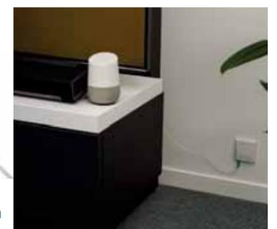
Câble de branchement intérieur connecté à la PTO ou DTIO
